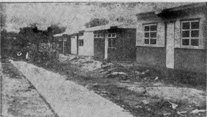
Las construcciones que realizaba el INVU en La Mora, interesante proyecto desarrollado, han concluido. Véase en la gráfica el aspecto de unas
