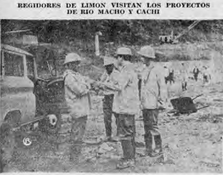
Con objeto de enterarse directamente de las obras que ejecuta el Instituto Costarricense de Electricidad, los señores regidores y autoridades del cantón central de Limón realizaron en días pasados una gira de estudio y observación a los proyectos hidroeléctricos de Río Macho y Cachi. El Vice-Presidente de la Corporación, los señores Carl E. Neil y Luis Moscoso, aparecen en esta fotografía recibiendo explicaciones del Sub Gerente del I.C.E., señor Joaquín Alberto Fernández. Con la inauguración de la planta hidroeléctrica de Cachi, Limón entrará a formar parte del sistema interconectado del I. C. E.
